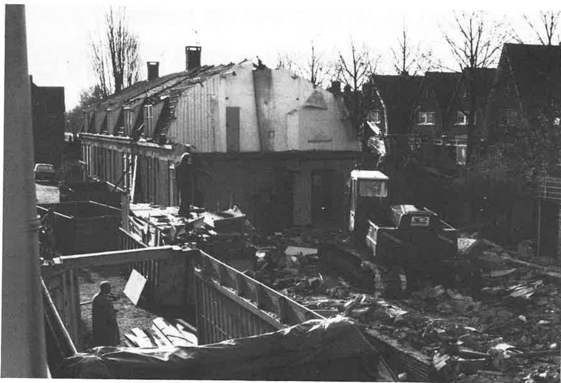
21 november 1983. De sloop is in volle gang, één westelijk blok is al verdwenen (nrs. 2 t/m 12).
