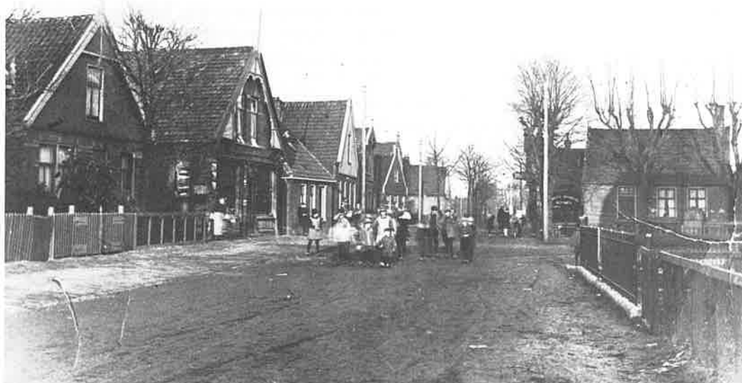
De Dorpsstraat na het dempen van de wegsloot; rechts het huis van H.B. Siemer. Dit werd in 1930 gesloopt en werd laatstelijk bewoond door de familie F. van Assema.
